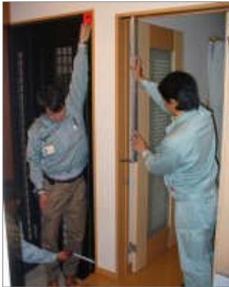
写真-1 柱傾斜の測定
