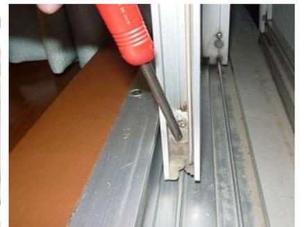
写真-6 サッシの建付調整口
