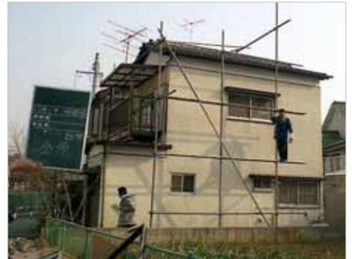
建物と実験の概要を上表に示しました。建物は在来木造2階建、間取りは3DK、外壁はリブ付きトタン張りの上からモルタルリシン吹き付けに改修しています。内壁は繊維壁、基礎はブロックのため掘削部分は撤去しました。
