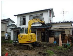
写真-1 重機強制加振
