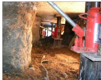
写真1 掘削と基礎の仮受け状況
