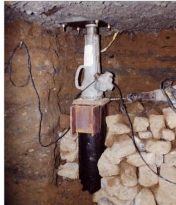
写真3 鋼管圧入(べた基礎)
